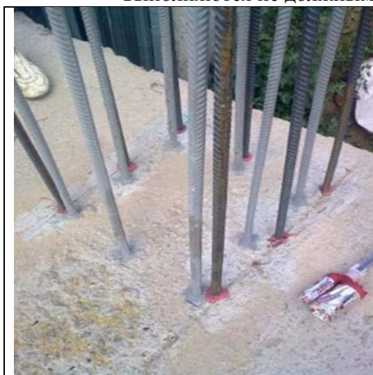
Рисунок 1. Отклонение от проектного положения выпусков колонны.
