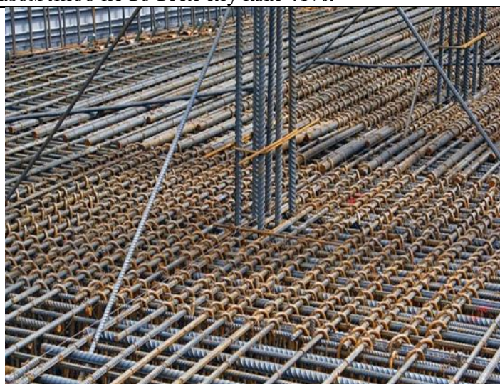
Рисунок 2. Закрепление выпусков для предотвращения отклонения выпусков колонны в процессе бетонирования.
