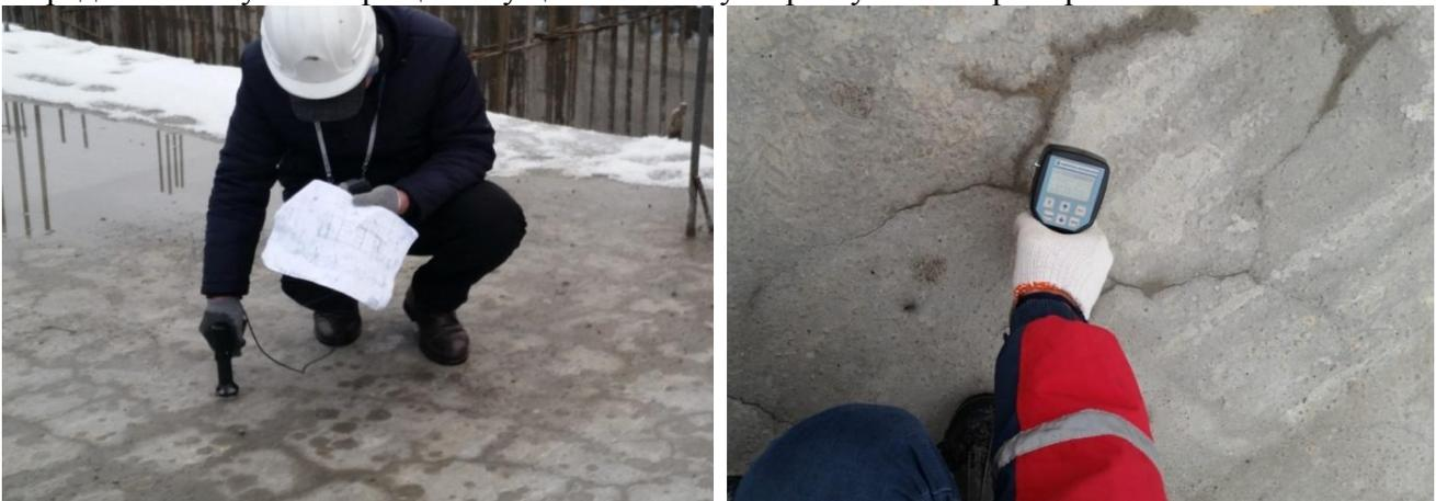
Рисунок 3. Определение прочности бетона фундаментной плиты, определение глубины трещин.
