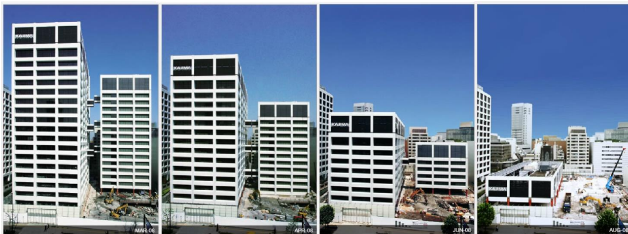
Рис. 1. Метод КС & TD использовался для сноса двух башен штаб-квартиры Кадзимы
