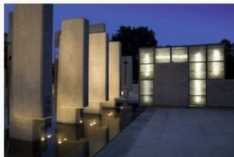
Рис. 2 Фасадные панели из прозрачного бетона
