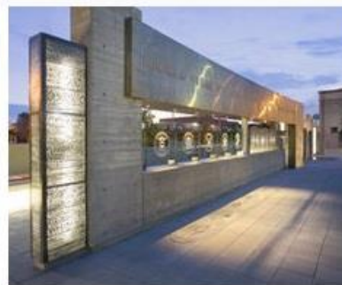
Рис. 2 Фасадные панели из прозрачного бетона
