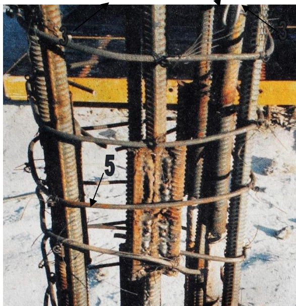
Рис. 2. Дефекты пространственных арматурных каркасов, допускаемые при изготовлении пространственных арматурных каркасов в проектном положении на этажах возводимого здания: 1 и 2 – хвост хомута не застёгнут т.к. угол загиба 90^\circ ; 3 - хвост хомута застёгнут т.к. угол загиба 180^\circ ; 4 - хвост хомута застёгнут т.к. угол загиба 180^\circ , но не натянут; 5 – хомут не натянут.
