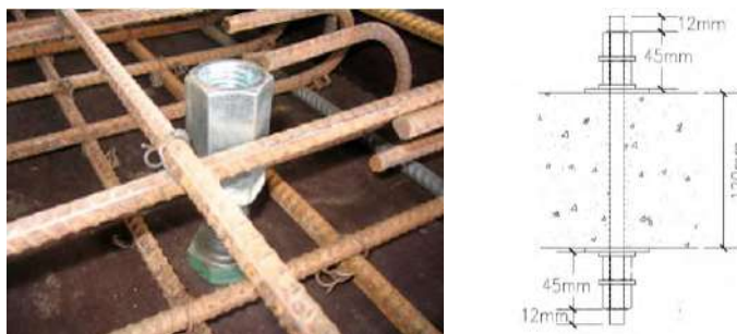
Рисунок 4. Установка GFRP-болта для усиления зоны продавливания колонны
