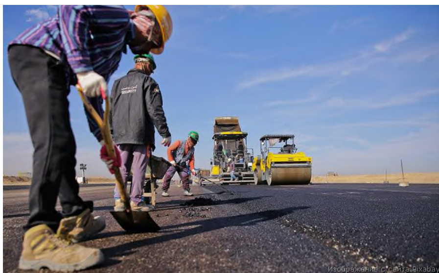
Рисунок 1. Процесс укладки покрытия
