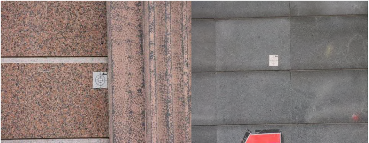
6-сурет – Ғимараттың төменгі бөлігіндегі геодезиялық шағылыстыратын пленкалар
