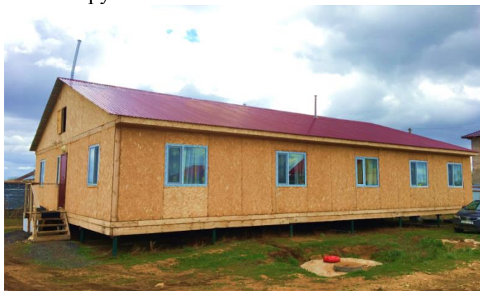
Рисунок 1 – Общий вид объекта на момент проведения технического обследования
