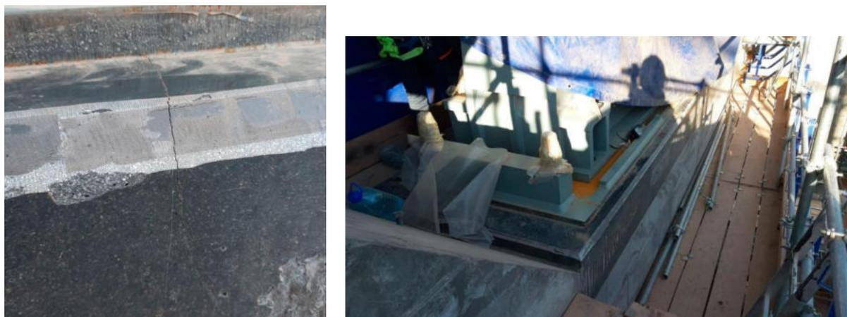
Рисунок 2. Температурно-усадочные трещины в подливке под оборудование (основание из полимербетона на основе эпоксидной смолы) шириной раскрытия до 0.3 мм и глубиной до 204 м.
