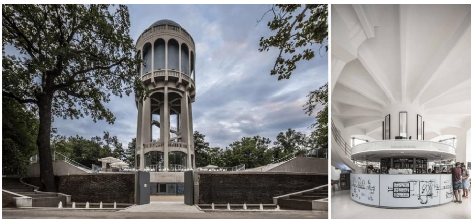
Рисунок 3. Водонапорная башня Nagyerdei Víztorony
