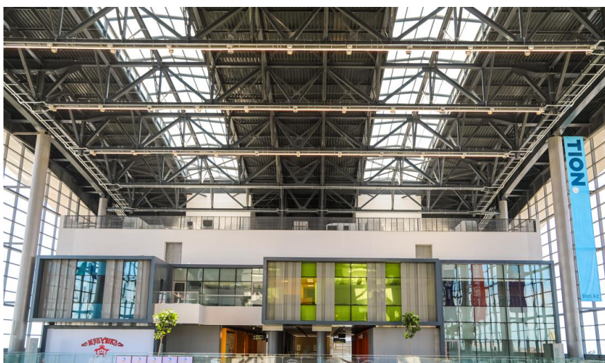
Рисунок 5. Железнодорожный вокзал «Нұрлы жол», 2017 г., г. Астана. Пример верхнего освещения [11].
