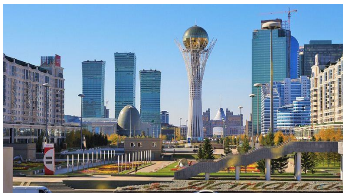
Рисунок 2. Застройка вокруг бульвара. Вид на Байтерек
