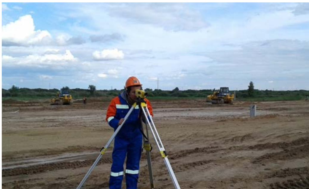
Рисунок 2. Наблюдение за погружением свай при помощи нивелира
