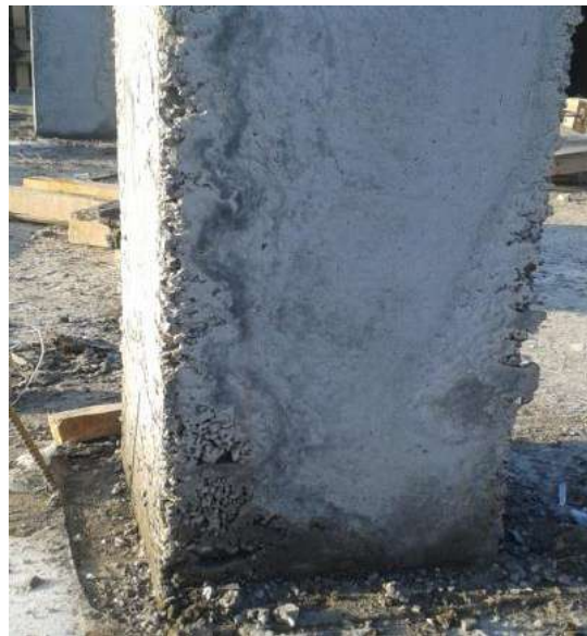
Рисунок 2. Некачественное вибрирование.
