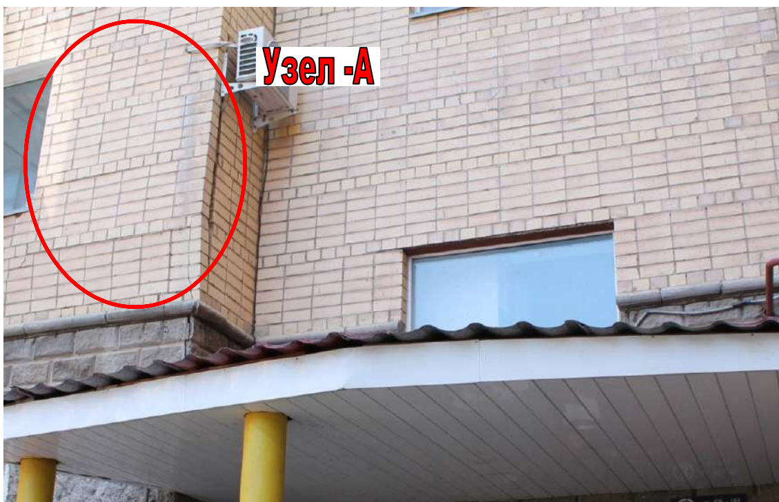
Фотофакт – Рис.4 Жилой комплекс по улице Мусрепова 29/1.
