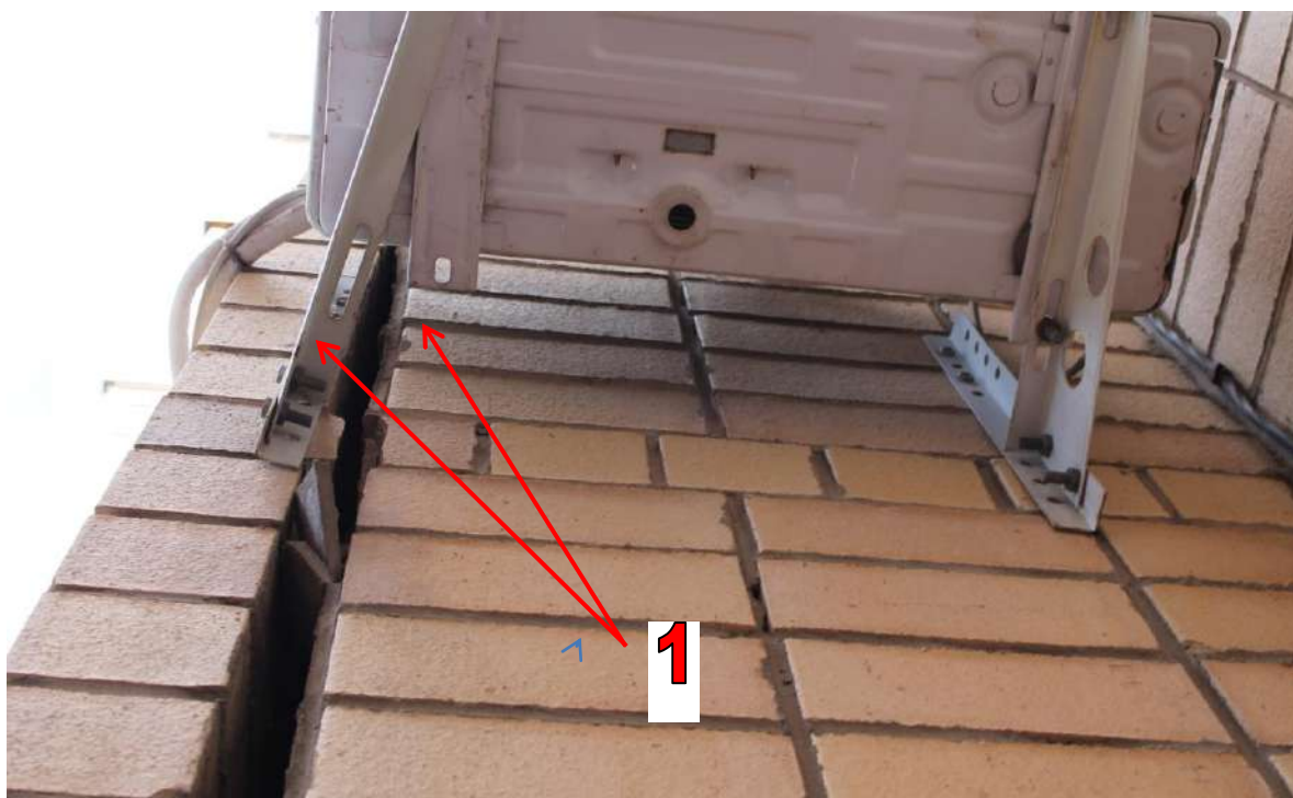
Фотофакт – Рис.6 Детализовка фотофакта – 5, узел –В: 1 – раздвижка узлов болтового соединения.
