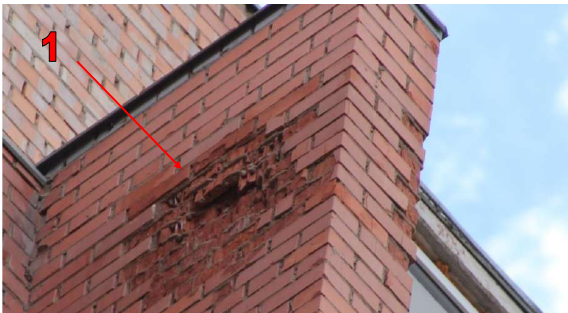
Фотофакт – Рис.3 Жилой комплекс по улице Кудайбердыулы 24/1. Блок – 3.
