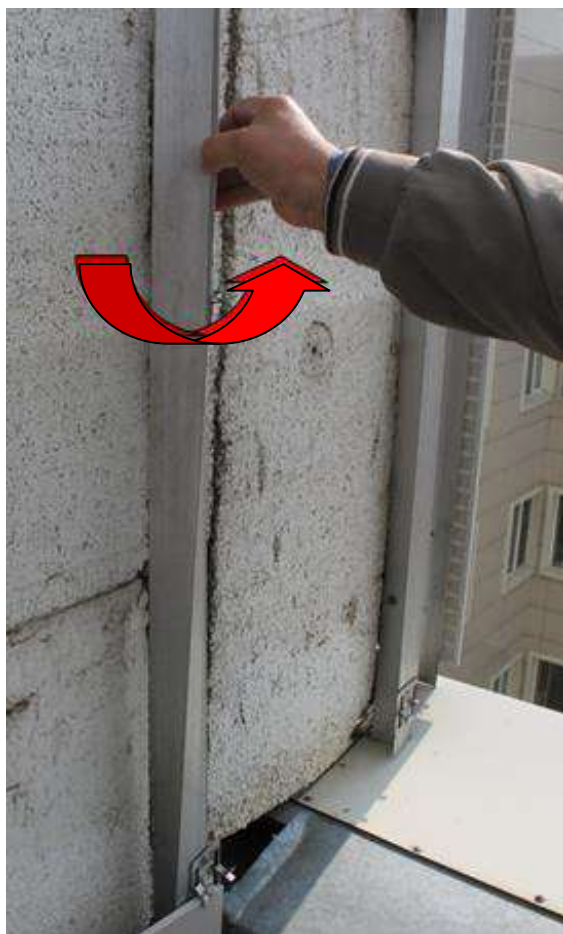
Фотофакт – 2. Свободное скручивание профиля - подтверждение недостаточной её жёсткости.
