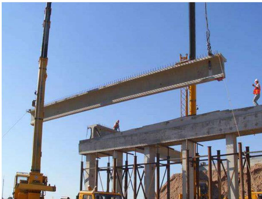
Рисунок 3. Монтаж балок пролетного строения на опоры. (Фото из архива Алматинского завода мостовых конструкций)
