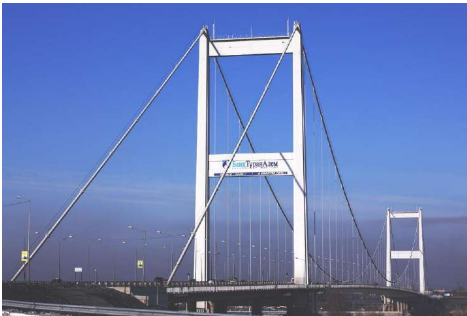
Рис.1 - Подвесной мост в г.Семей
