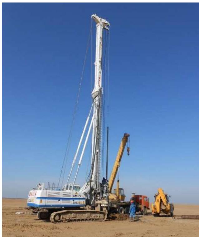
Рисунок 1 – Устройство и испытания свай СФА
