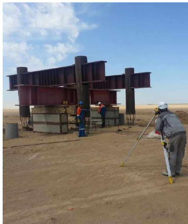
Рисунок 1 – Устройство и испытания свай СФА
