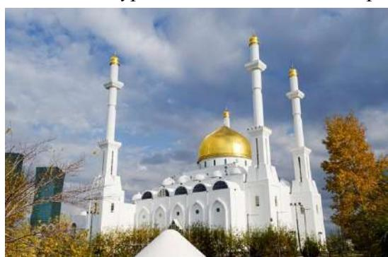
[Султан](#) являлась самой большой мечетью в [Казахстане](#) и в [Центральной Азии](#). Мечеть имеет четыре минарета высотой по 62 метра, высота главного купола 43 метра, а общая площадь равна 3930 кв. метров. Конструкция выполнена из стекла, бетона, гранита и алюкобонда меры. В здании мечети могут молиться сразу до 5 000 человек.
