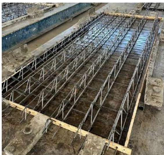
Рис. 2 Готовая арматура для плиты
