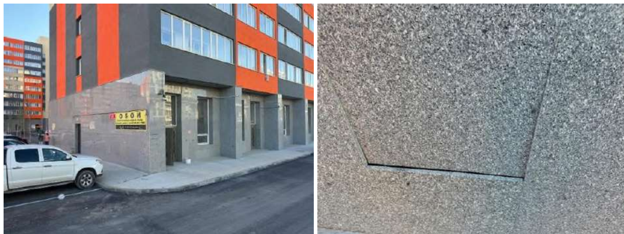
Рис. 3 Фрагмент каменной отделки стены из фундаментных блоков гранитными плитами
