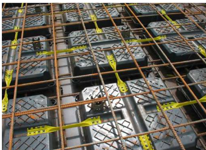
Рисунок 3. Общий вид несъемной опалубки, установленной на внешней опалубке и смонтированным нижним и верхним армированием плиты (до укладки бетонной смеси)
