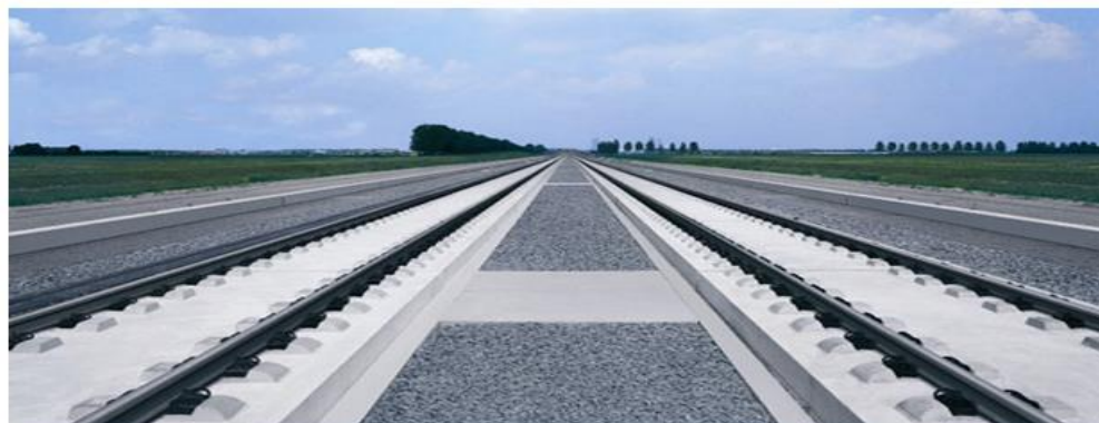
Рисунок 2 - Безбалластное верхнее строение пути для ВСМ
