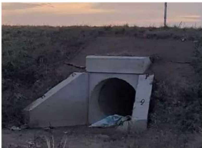
Рисунок 15 - Водопропускная труба
