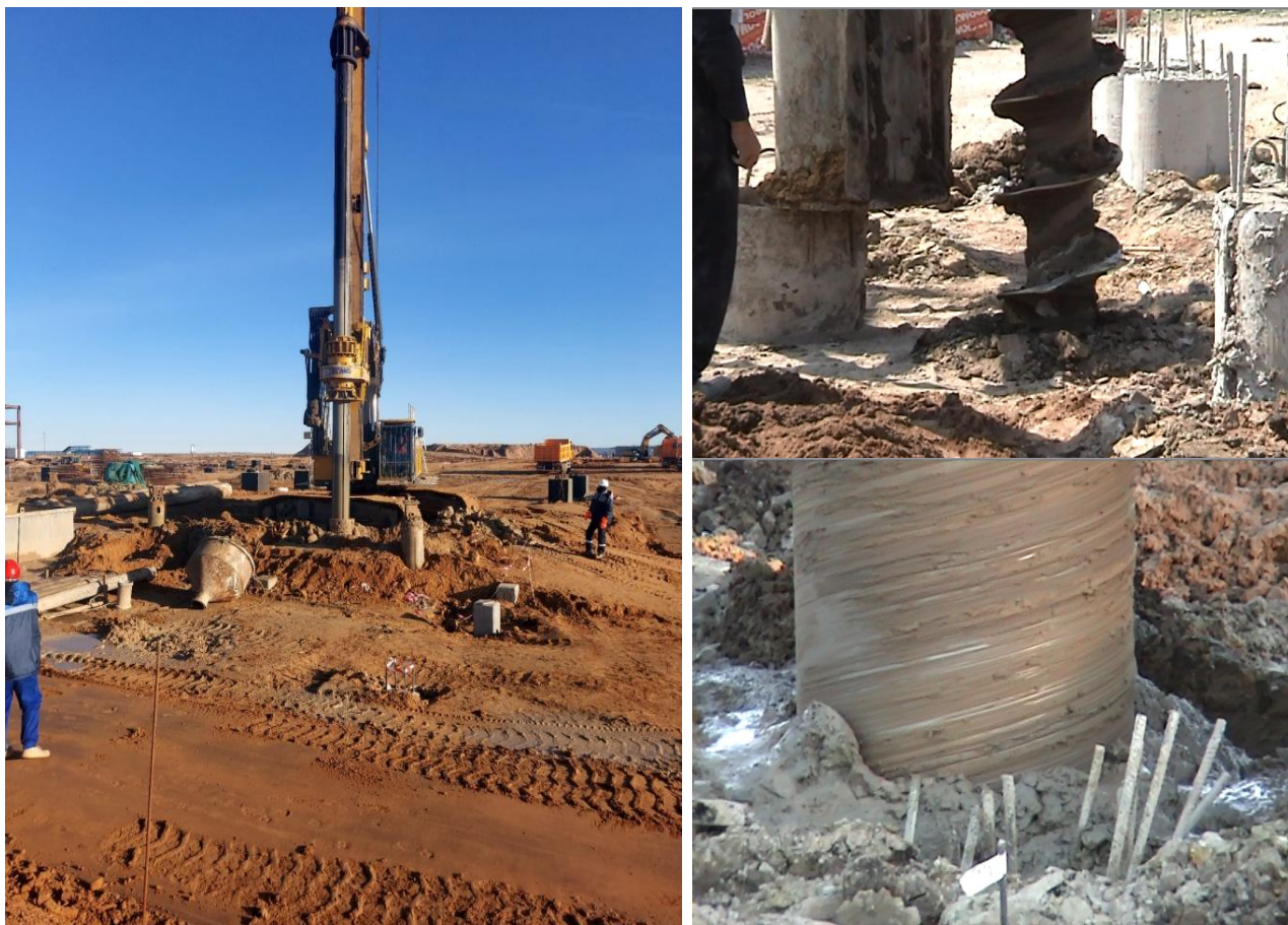
5.2-сурет - Астана қаласындағы іргетас құрылысы кезінде бұрғыланған қада технологиясын қолдана отырып, қадаларды орнату
