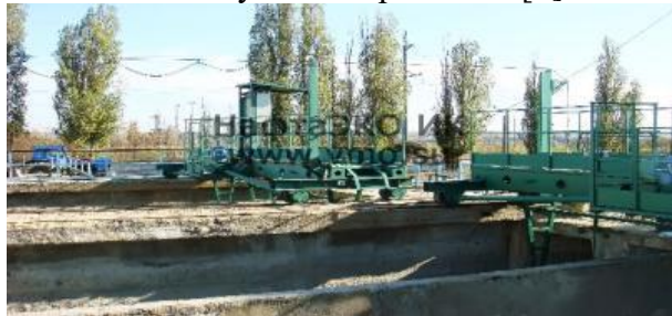
Рисунок 3 - Скрепковый механизм: цепной и тележечный
