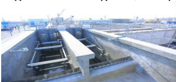
Рисунок 3 - Скрепковый механизм: цепной и тележечный
