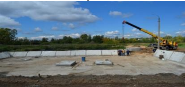
Рисунок 4 - Песковая площадка и бункер
