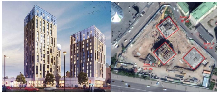
Рисунок 1 – Общий вид АЖК «Астория» и снимок объекта на момент строительства
