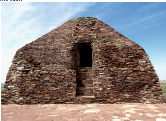
Рис 6. Мазар Домбаул после консервационных работ
