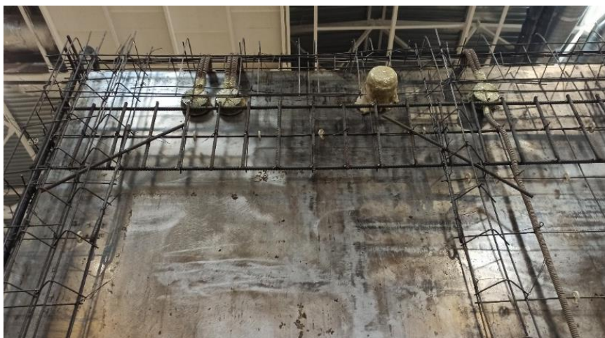
Рисунок 5. Армирование проема стержневым каркасом класса А500С
