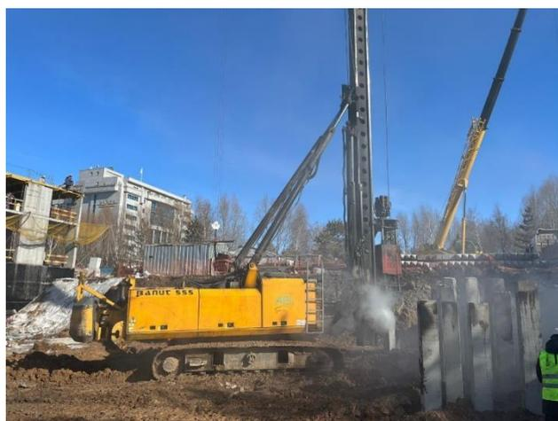
Рис.1 – Работа сваебойной машины на строительной площадке
