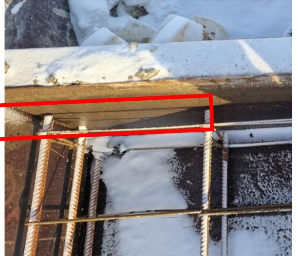
Рисунок 1-2. Отсутствие защитного слоя бетона и снег на поверхности опалубки
