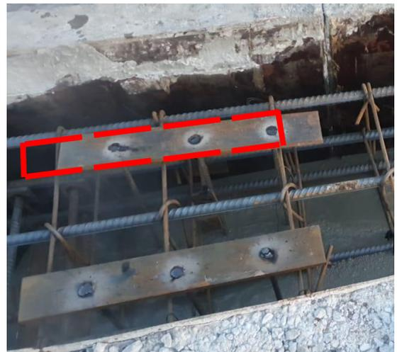
Рисунок 4. Смещение закладных деталей от проектного положения
