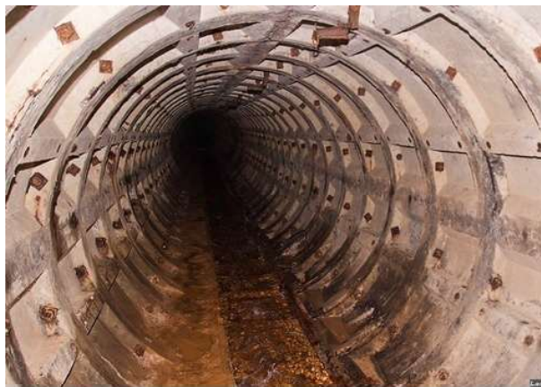
Рисунок 1 – Укрепленный подземный тоннель в массиве горных пород
