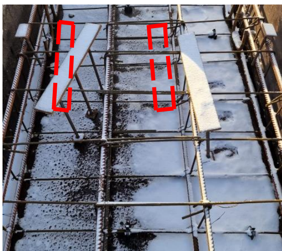
Рисунок 3. Смещение закладных деталей от проектного положения
