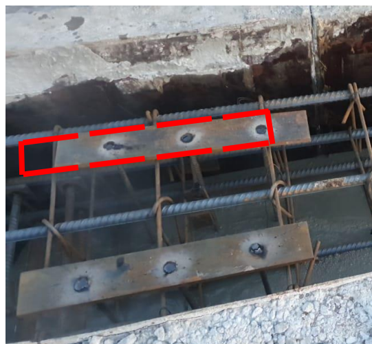
Рисунок 4. Смещение закладных деталей от проектного положения
