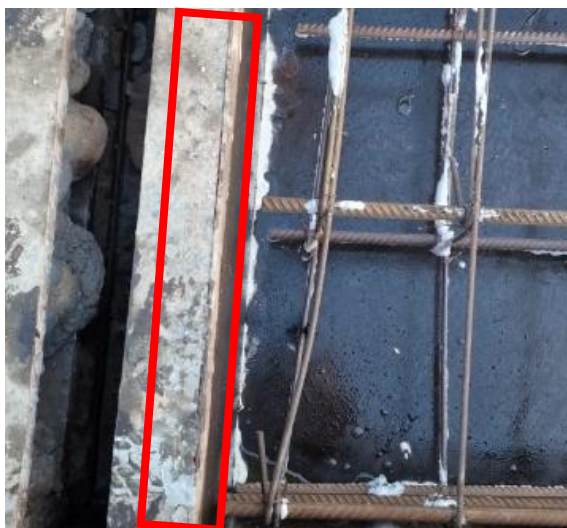
Рисунок 1-2. Отсутствие защитного слоя бетона и снег на поверхности опалубки
