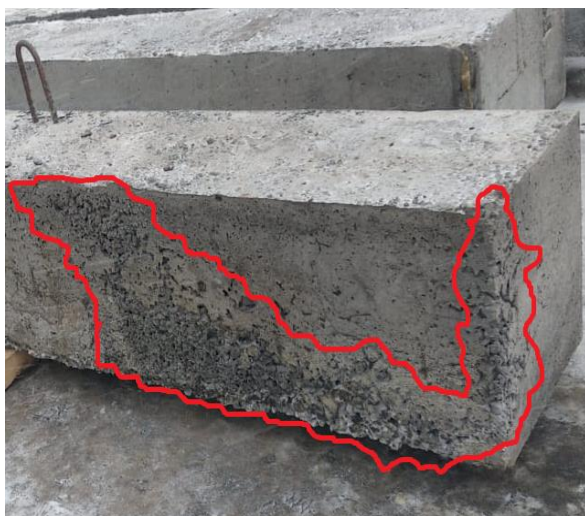
Рисунок 5. Образование раковин в теле бетона
