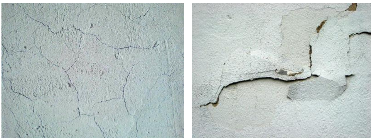
Рисунок 2. Расслоение кладки и выпадение отдельных камней, образование трещин.
