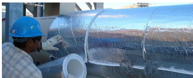
Рисунок 2. Утепление трубопровода с помощью аэрогеля
