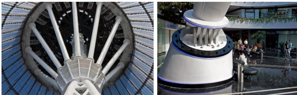
Сурет 2 - Трипод конструкциялары; а) себет; б) топсалы байланыс
