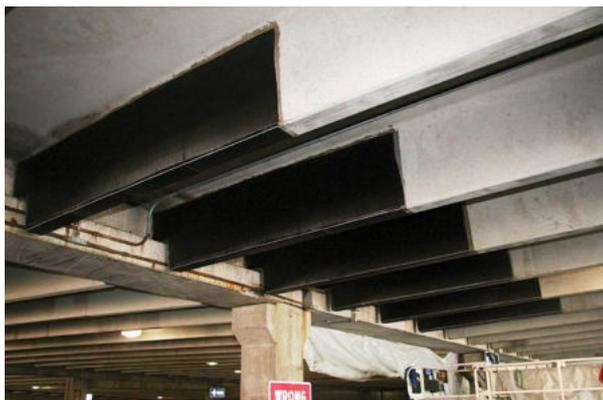
Рис. 1. Пример усиления композитными материалами (Система холстов).
